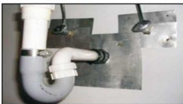
墙上的孔洞用硬物封闭(或堵塞)
