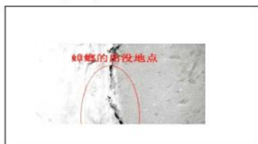
填补墙上缝隙,尤其是操作间水池下、灶台下的缝隙,减少蟑螂孳生
